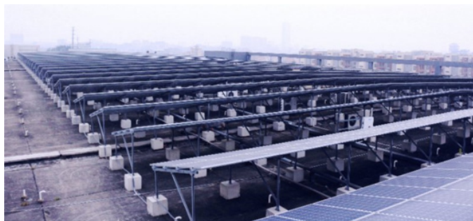
太陽能光伏發電站
